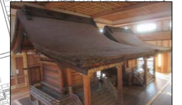
八幡神社（覆屋建替工事完成）
