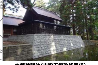
大館神社（本殿玉垣改修完成）
