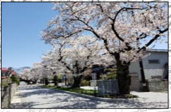
桜並木通り（幸町地区）植樹帯・路側側溝・街路樹整備 電線類統合・路面美装化完成
