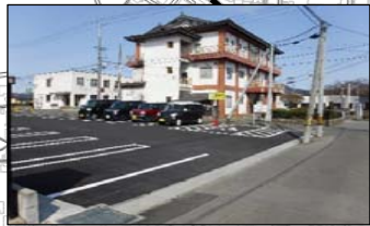
三ノ丸地区駐車場整備完成（効果促進事業）
