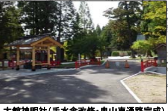
大館神社（手水舎改修・曳山車通路完成）
